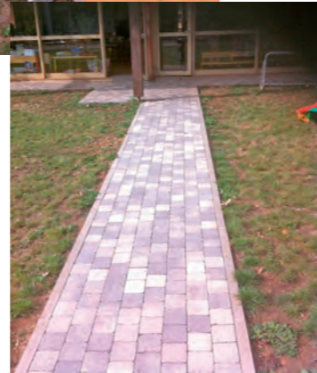
Fin de chantier...
