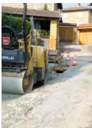
Pendant les travaux
