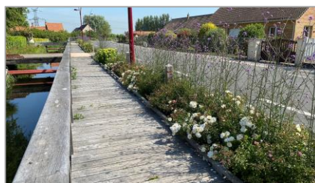
Traitement des cheminements doux et mise en sécurité des piétons dans un milieu contraint (fossé en eau) par un cheminement en platelage bois (Saint-Folquin (62)). Source : CAUE
