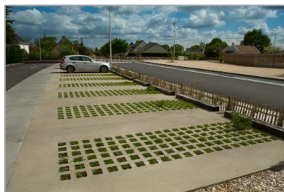
Béton coulé végétalisé en place
