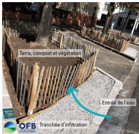
Principe de l'arbre de pluie.
