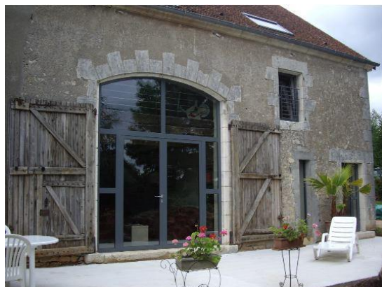
Illustration de fermetures vitrées de porte de grange à vitilleries
