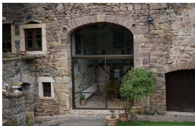
Illustration de fermetures vitrées de porte de grange à vitilleries
