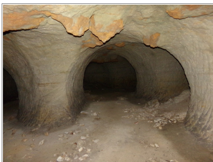
Figure IV 1: exemple de paquet de matériaux argileux suspendus au ciel de la cavité 2.
