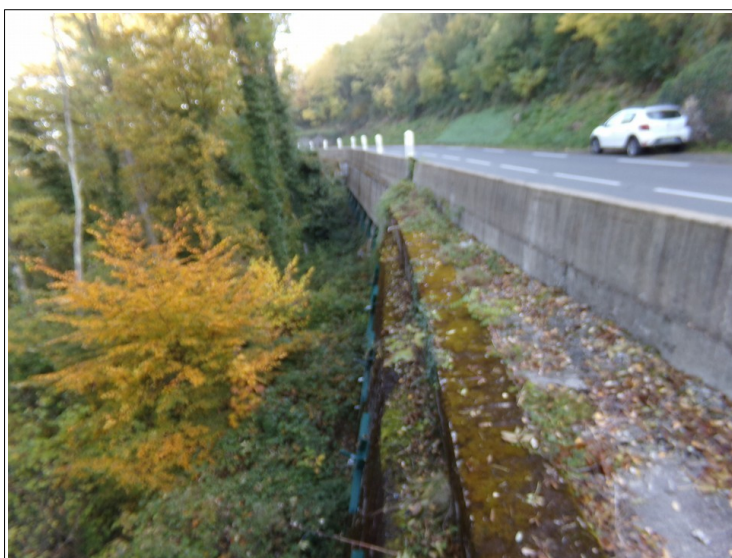
Figure III 4: ouvrage de soutènement de la RD338 au niveau du glissement de terrain des années 1990.
